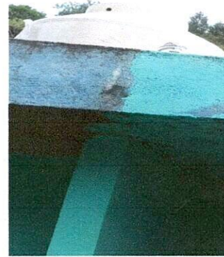
Foto 4: Reparacion de Deposito de Agua.
