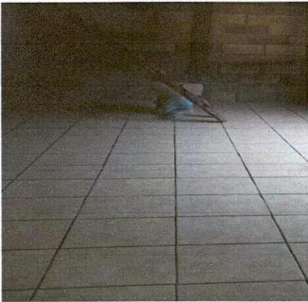
Foto 3: Mejoramiento Aula (Piso)
